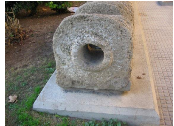
Πέτρα αγκύρωσης του μολύβδινου αγωγού υπό πίεση
